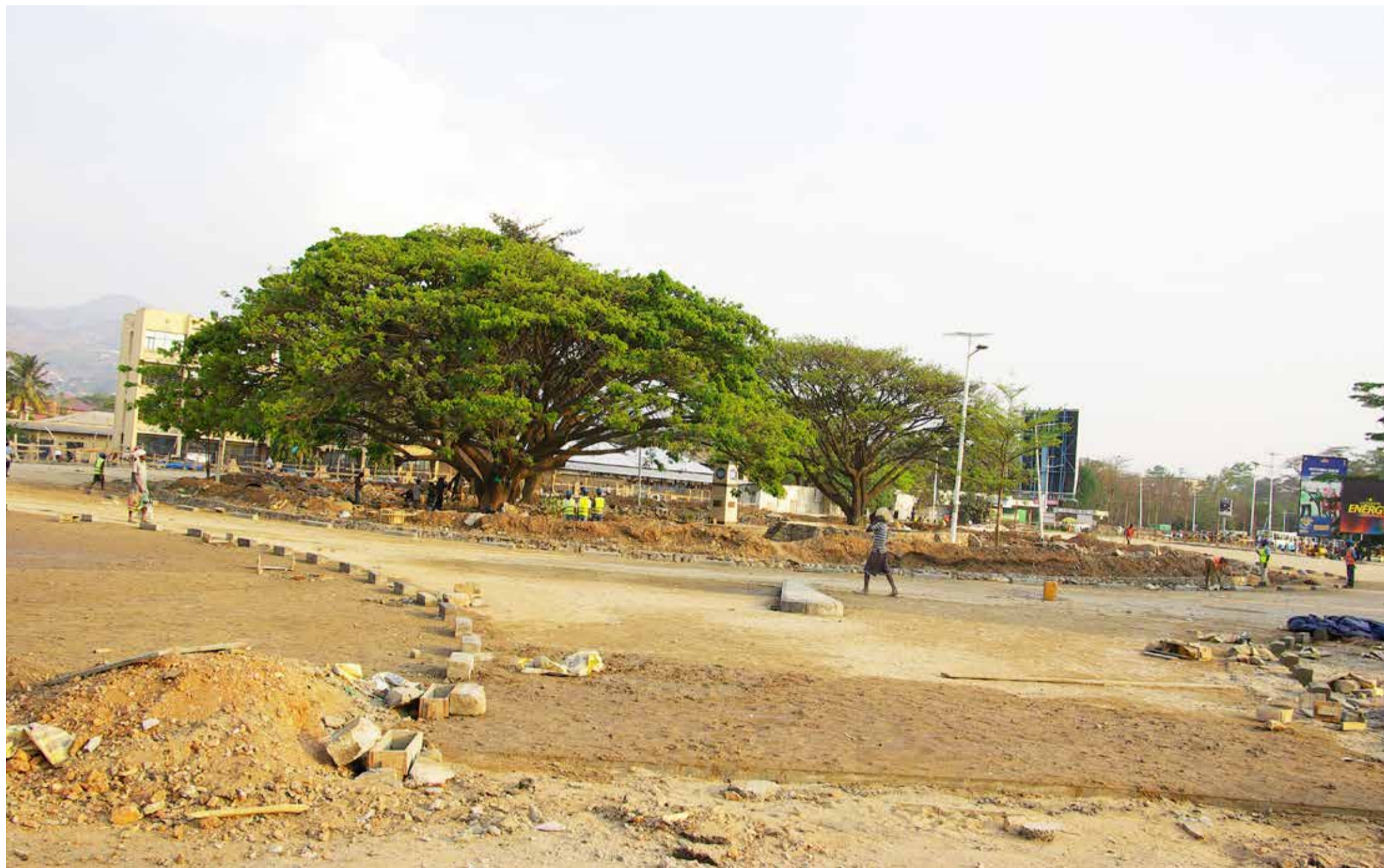
Les travaux de réfection du rond-point des Nations-Unies sont en passe d'être clôturés. Les usagers de la route attendent impatiemment la rouverture de ce tronçon pour une bonne circulation routière
