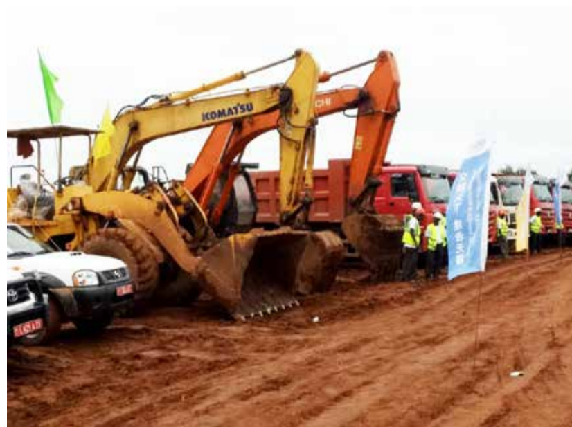
Des engins commencent les travaux de bitumage du tronçon Taba-Gakuba
