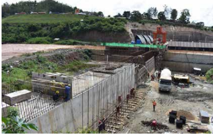
Centrale hydroélectrique régionale, Rusumo Falls en construction sur la rivière Kagera. Elle fournira 26,5 MW au Burundi.
