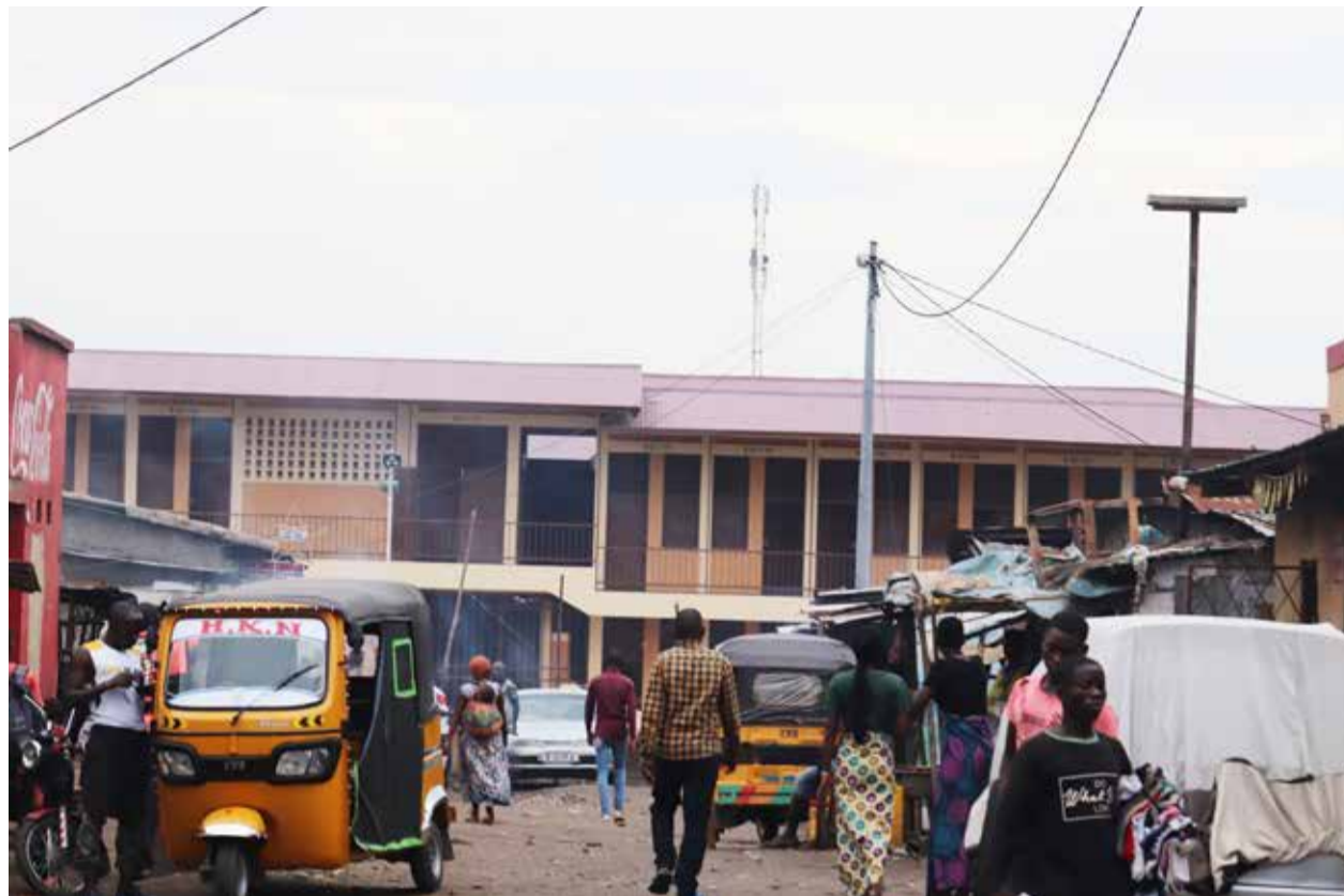
Les travaux sont à 99%. La réouverture de ce marché prévue pour novembre.
