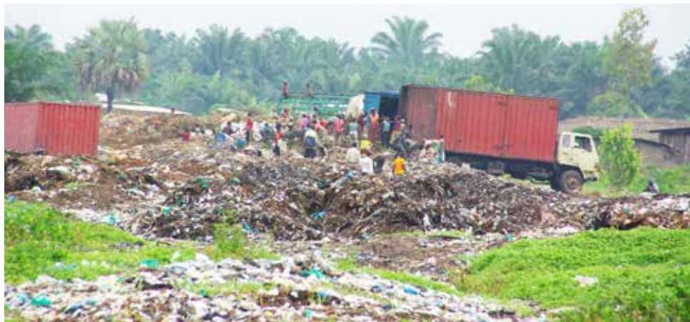
Le dépotoir de Mubone n'est plus praticable. Il a été suspendu suite à son inaccessibilité par les camions de décharge
