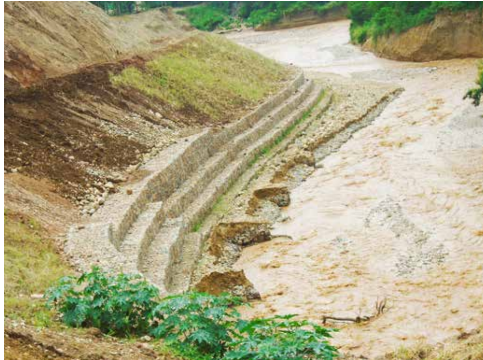
Les travaux d'urgence (murs en gabion) pour protéger les infrastructures riveraines de la rivière Ntakangwa
