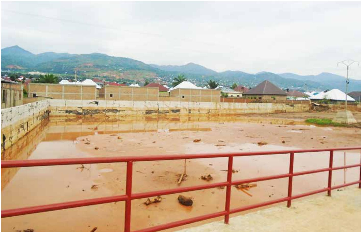
Bassin d'écrêtement construit sur la rivière Gasenyi pour dompter les inondations au quartier Carama
