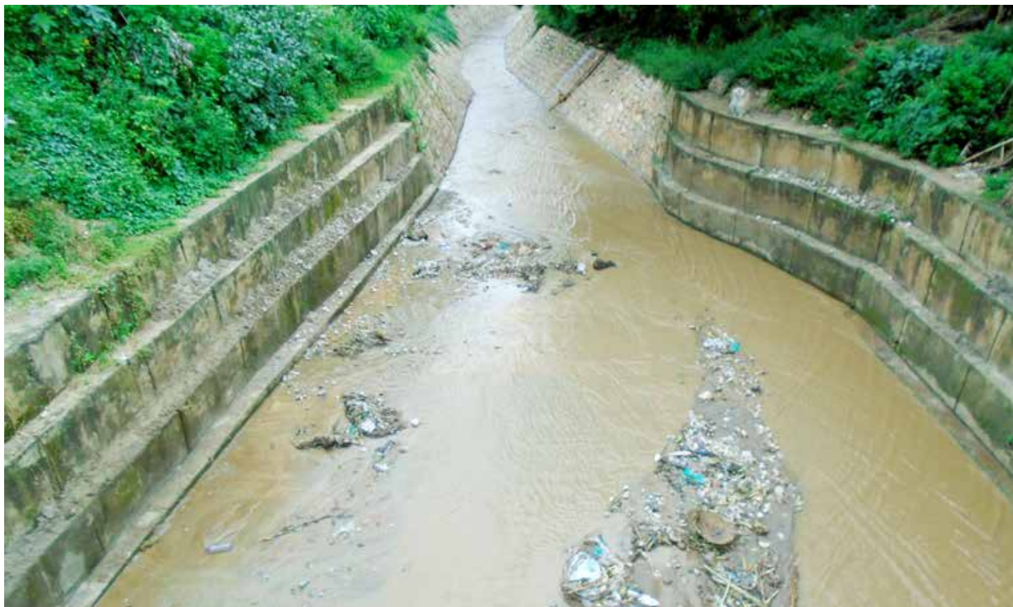
Rivière Nyabagere réhabilitée
