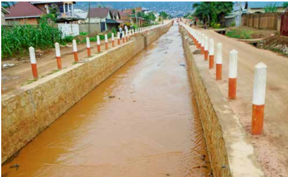
Rivière Gasenyi réhabilitée
