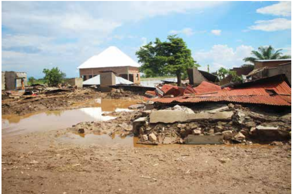
Les infrastructures se sont affaissées suite aux inondations au quartier Buterere
