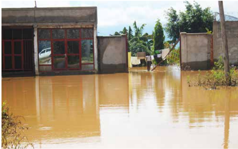
Les infrastructures inondées au quartier Buterere
