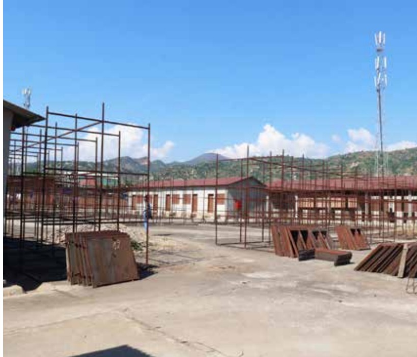
À l'intérieur du marché de Kanyosha, les travaux sont toujours en cours.
