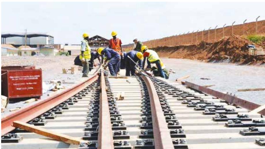
Les voies ferrées sont constituées de files de rails dont l'écartement (la distance entre les deux rails) fait l'objet d'une réglementation très précise.
