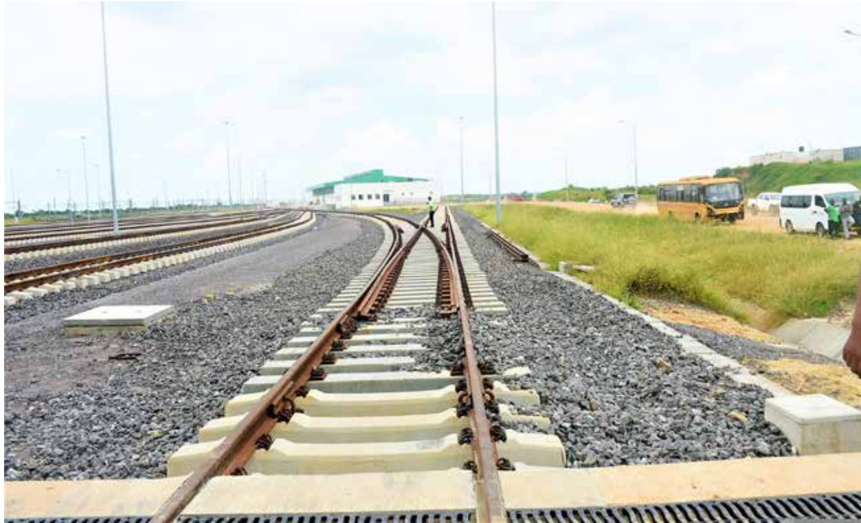
Si rien ne change, au mois de juillet 2024, on va lancer la construction de ce chemin de fer, surtout pour le tronçon Uvinza-Musongati.
