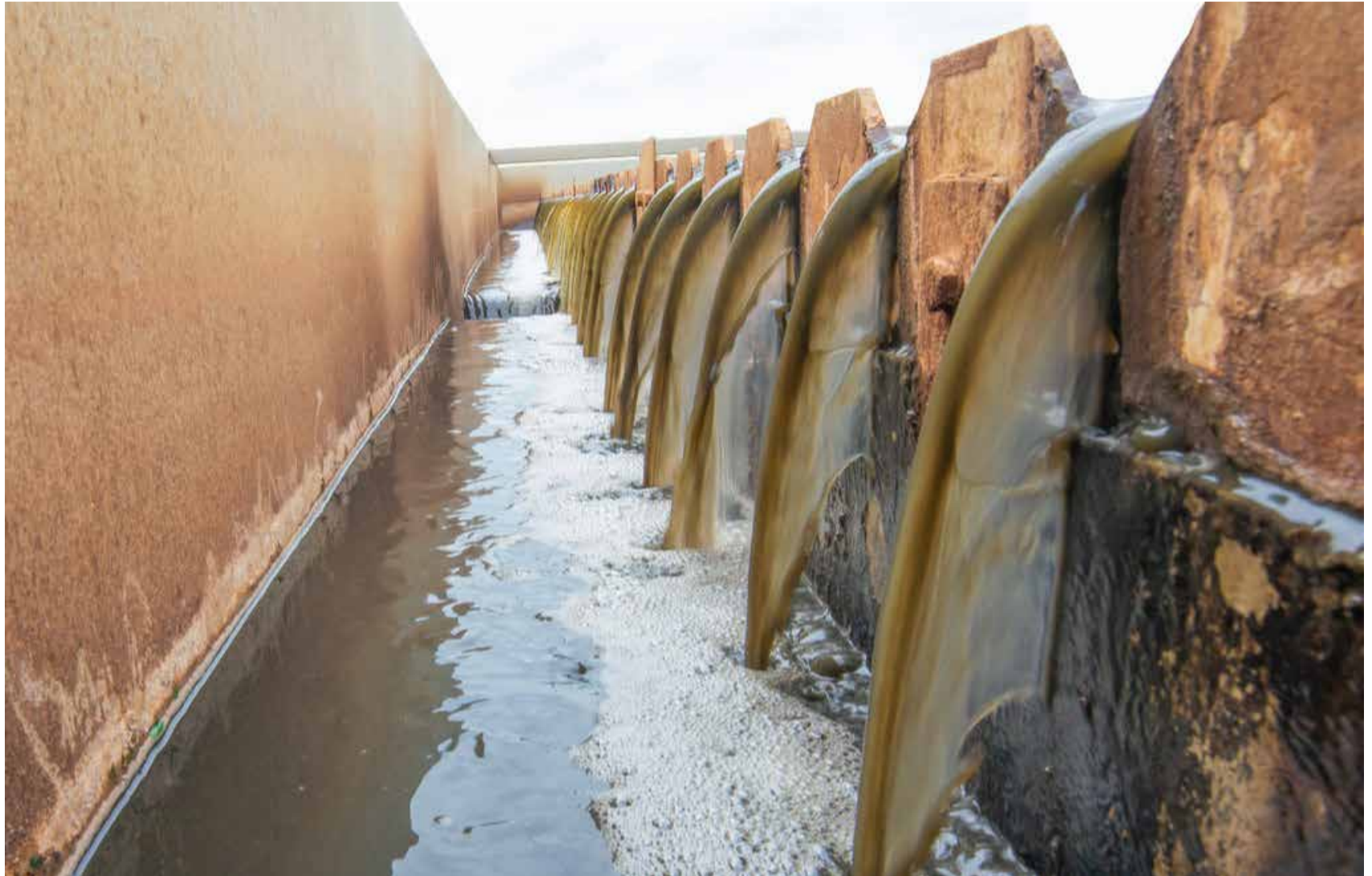
Pour améliorer la gestion des déchets liquides, une usine de traitement des boues fécales a été construite à Dar-es-Salaam en Tanzanie.
