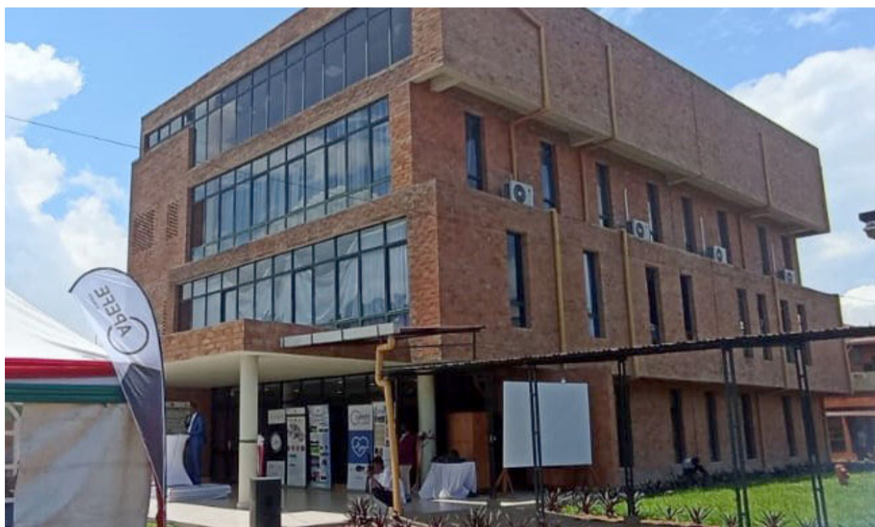
Le bâtiment abritant le service de kinésithérapie, la filière de formation et le centre de recherche en kinésithérapie et réadaptation à l'INSP de Bujumbura.
