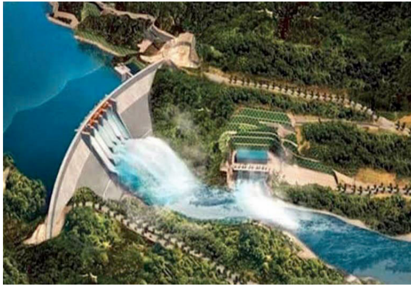
La centrale hydroélectrique de Julius Nyerere qui produit 2115MW d'électricité en Tanzanie.
