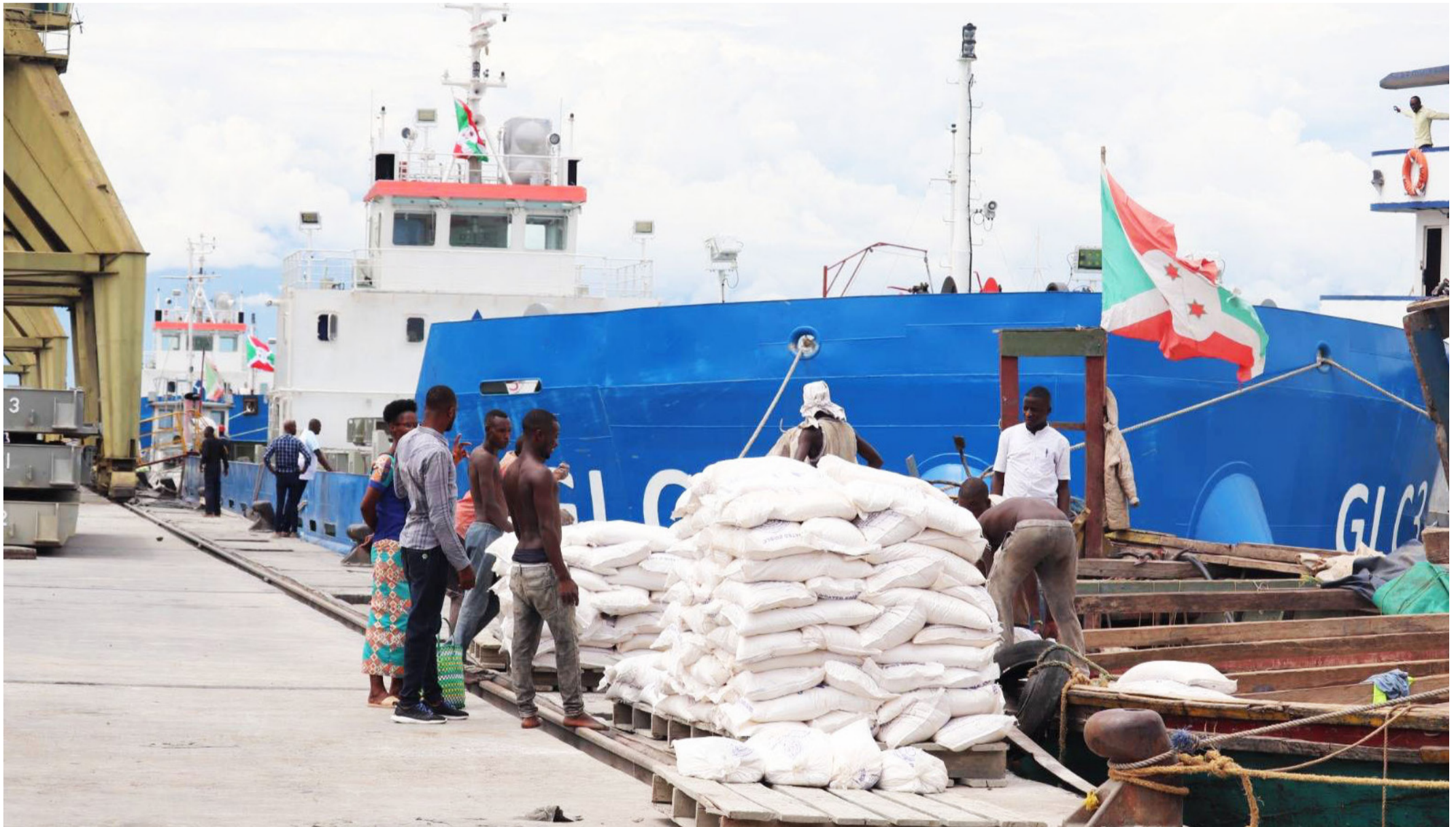
Le chantier de modernisation et de réhabilitation du port de Bujumbura vise à transformer cette infrastructure en une plaque tournante.
