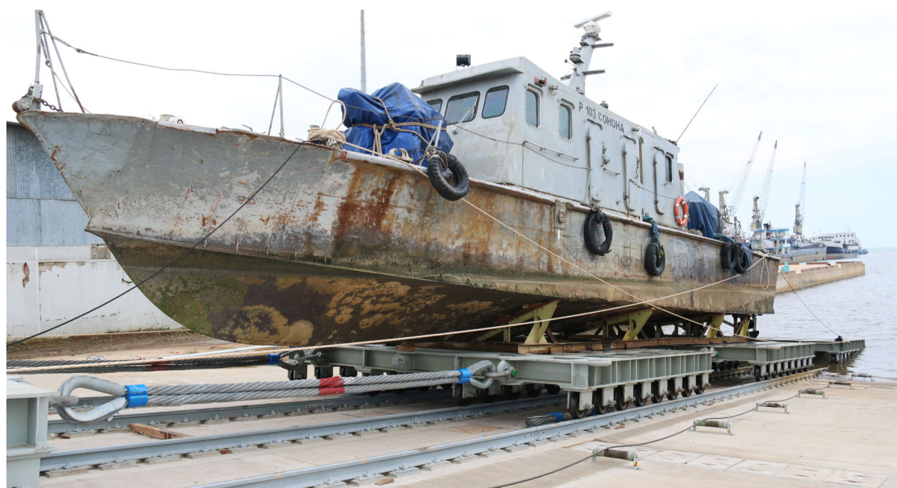
Le chantier naval moderne au port de Bujumbura vient répondre aux besoins énormes de réparer et d'inspecter les bateaux immatriculés au Burundi qui devaient auparavant faire recours aux ports de Kigoma et de Kalemie en cas de réparation.
