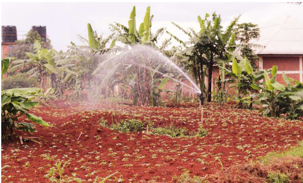
L'installation d'un système d'irrigation collinaire sous forme d'aspersion permettra à la congrégation des Frères de Notre-Dame de la Miséricorde de Nyabikere de produire des semences de qualité pendant la saison sèche.
