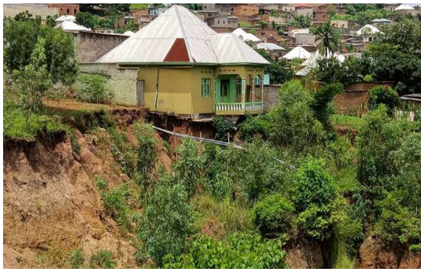
Au fil du temps, de simples crevasses se transforment en ravins massifs, détruisant des maisons, des routes et des ressources naturelles.
