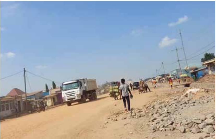
La réhabilitation de la route nationale RN9, au niveau tronçon reliant le rond-point des Nations unies au quartier Carama à Bujumbura, avance à un rythme jugé insatisfaisant par les usagers, avec des travaux qui suscitent des inquiétudes quant au respect des délais et à la qualité des réalisations.
